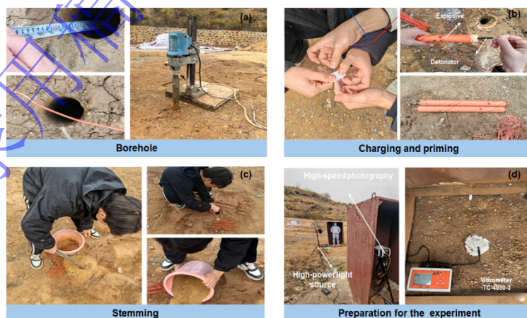
图 4 爆破原位试验试验流程
