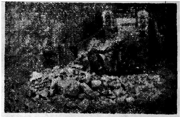
图9 导爆管起爆块度均匀
