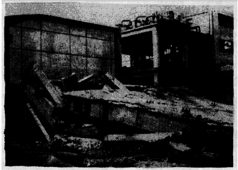
图3 滤机房炸后景况
