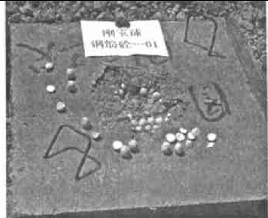
图5 试验后的刚玉块石钢筋砼靶体
