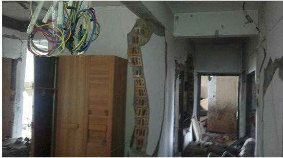
图 4 爆炸后室内走道区,烧结多孔砖填充墙破坏
