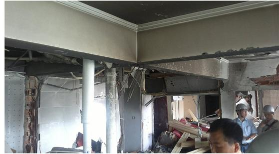
图 5 爆炸后客厅区,四周填充墙被冲击倒
