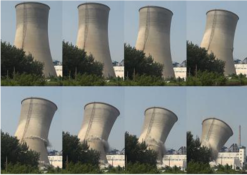
图 4 冷却塔爆破倒塌过程图
