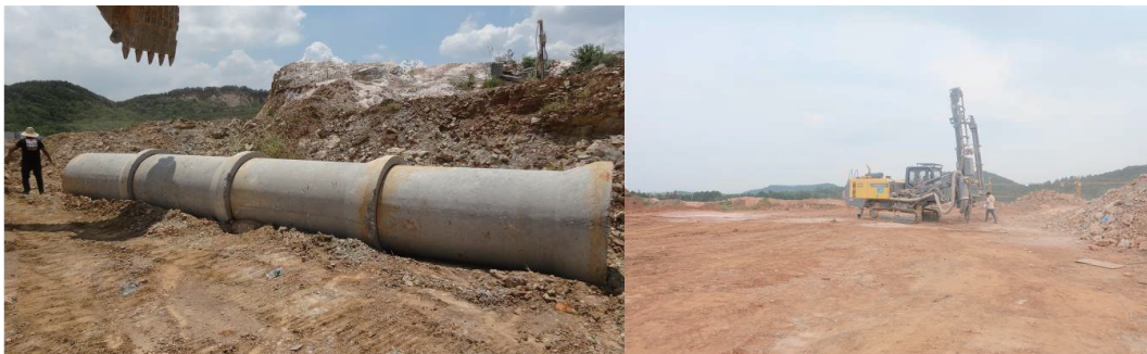
图 1 现场管道埋设与炮眼钻孔
