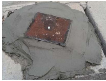
图3 振动传感器安装基座
