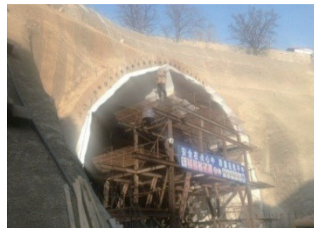
图 4 草帽山隧道进口工区 [20]
