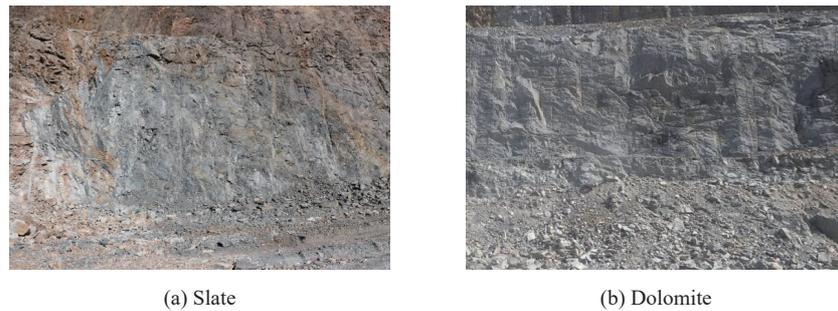
图 22 常规预裂爆破效果
