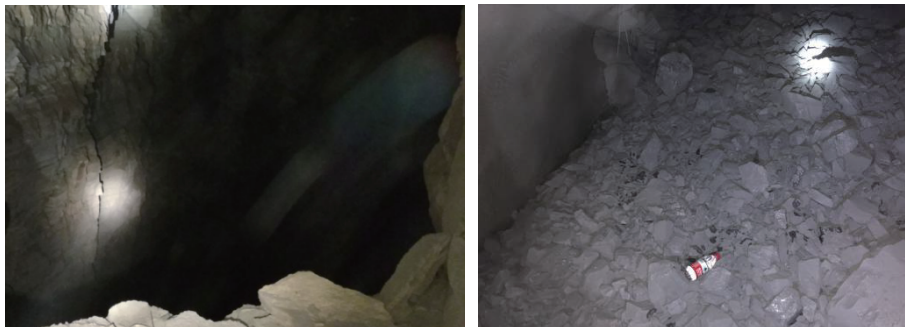
图 23 底部空气间隔装药爆破的顶板和爆堆
