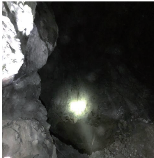
图 22 未采用底部空气间隔装药时的顶板
